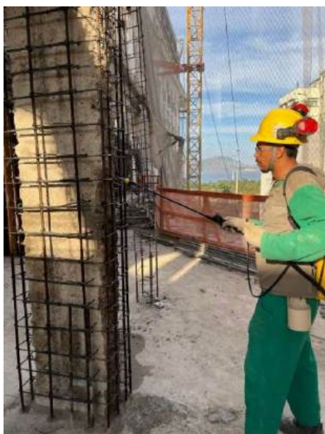
Figura 13. Aplicação do inibidor migratório de corrosão por aspersão em um dos pilares do Bloco 2.
