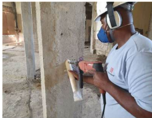
Figura 5. Coleta de material do Bloco 2 para o ensaio de cloretos.
