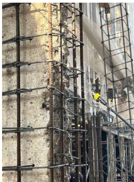
Figura 14. Detalhe da aspersão do inibidor de corrosão em formato de “leque”
