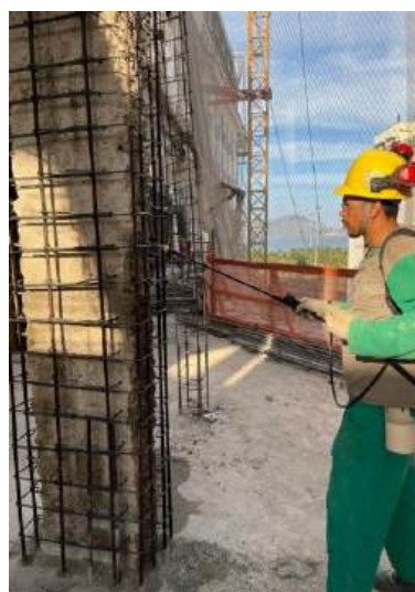
Figura 14. Inibidor de corrosão aplicado nas obras de reparo e recuperação estrutural do retrofit do Hotel Glória no Rio de Janeiro (RJ) Fonte: CHIARI et al. (2025)
