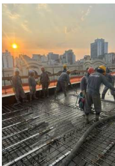
Figura 11. Concretagem da estrutura do SESC Parque Dom Pedro II em São Paulo (SP) com inibidor de corrosão em seu traço.
