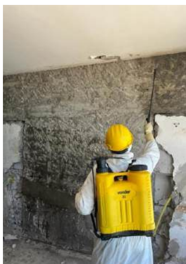
Figura 13. Aplicação do inibidor na reabilitação estrutural do Hotel Sofitel Ipanema no Rio de Janeiro (RJ) Fonte: Elaboração própria
