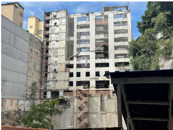
Figura 17a – “Esqueleto” existente do Bloco 3 que foi preservado para a execução da estrutura nova. Fonte: Elaboração própria
