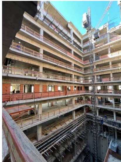
Figura 15b – Vista externa dos pavimentos do Bloco 1 durante a execução dos reforços. Fonte: Elaboração própria
