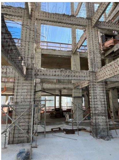
Figura 16a – Reforços dos pilares do “esqueleto” do Bloco 2. Fonte: Elaboração própria
