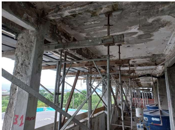
Figura 6 – Estrutura existente escorada. Fonte: Elaboração Própria
