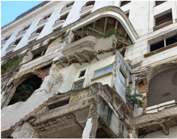
Figura 3 – Fachada original do Hotel Glória parcialmente demolida. Fonte: Elaboração Própria
