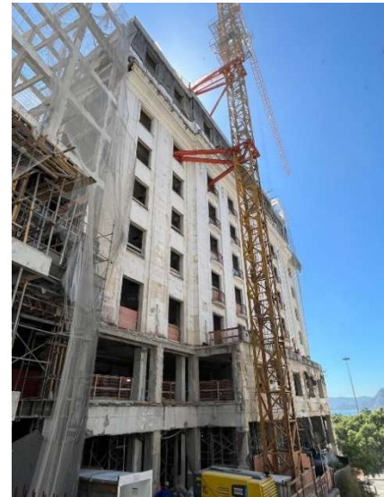
Figura 15c – Fachada lateral do Bloco 1. Fonte: Elaboração própria
