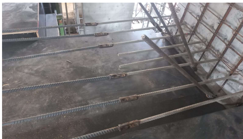
Figura 14 – Arranques emendados mecanicamente pela luva soldável que foram complementados e utilizados no projeto do Bloco 1. Fonte: Elaboração própria
