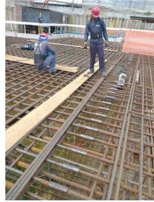
**Figura 10. Aplicação das luvas prensadas.**
