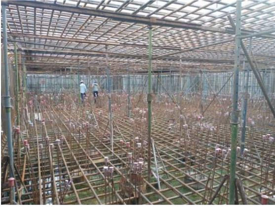
**Figura 9. Vista interna do radier armado.**
