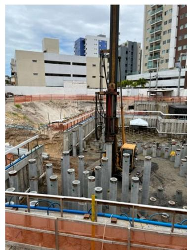
**Figura 7. Perspectiva do radier estaqueado. Figura 8. Cravação das estacas pré-moldadas.**
