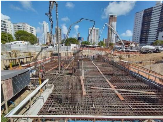
**Figura 11. Início da concretagem do radier.**
