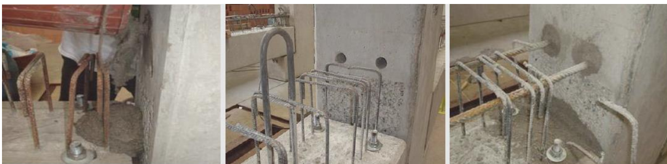
Figura 5 - Grauteamento de bainha: inserção do graute, furo das bainhas e armadura já grauteada (da esquerda para direita).
