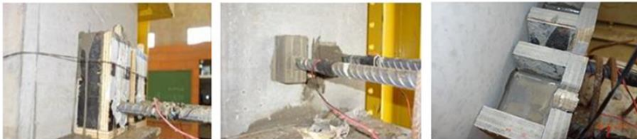
Figura 6 - Preenchimento das bainhas com graute por meio de vasos comunicantes
