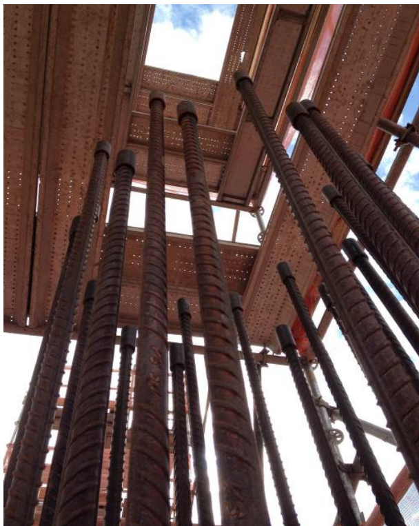
Figura 3 – Detalhe de utilização das luvas de aço rosqueada tipo cônica no Centro Paralímpico Brasileiro em São Paulo (2014).
