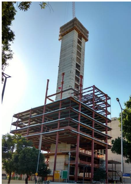
Figura 4 – Estrutura mista de um edifício comercial com as luvas de aço instaladas na estrutura de concreto no Rio de Janeiro (2015).
