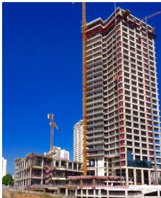
Figura 7 – Vista lateral do shopping center do complexo Parque da Cidade São Paulo (CHIARI et al. (2016)).
